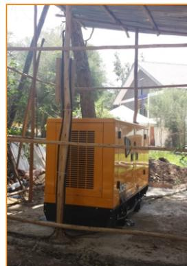
Um den Abschaltungen vom Strom zu begegnen hat das Center einen **neuen Generator** installiert. Da die Dieselkosten hoch sind kann das nur eine Zwischenlösung sein. Ein eigener Transformator für die Schule würde eine langfristige Verbesserung bedeuten. Strom wird für die Hostienbäckerei und das Essenkochen gebraucht.
